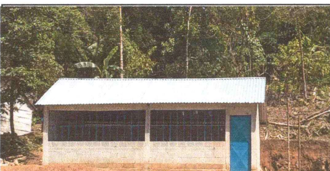
Foto 5: Se mejoro el piso que se encontraba en mal estado.
