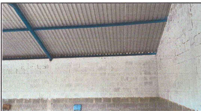
Foto 3: Se sustituyeron costaneras.
