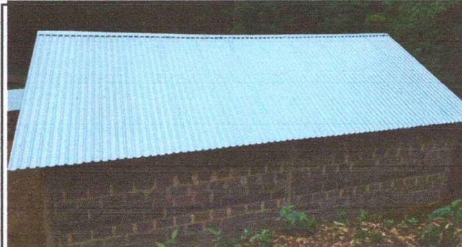
Foto 2: se sustituyeron laminas en mal estado.
